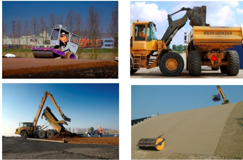
Слика 9. Уградња TRISOPLAST-а
